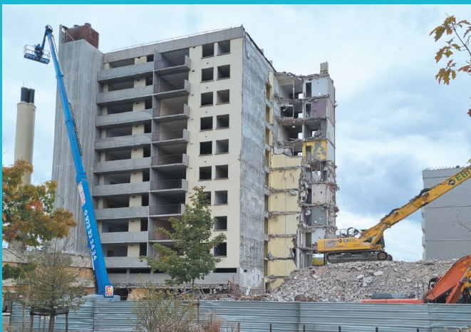
Démolition tour Schweitzer - Saumur
