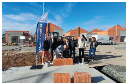
Pose 1 ère pierre Vaulanglais à Saumur
