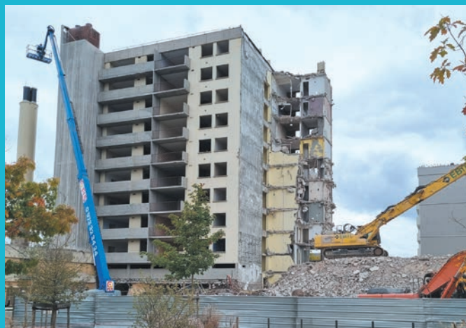
Démolition tour Schweitzer - Saumur
