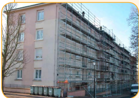
Réhabilitation de Schuman
