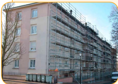
Réhabilitation de Schuman
